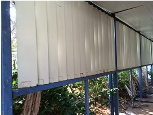
Image 33: Asbestos louvers
